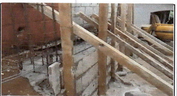
FOTO 6: Reparación de muro de contención
