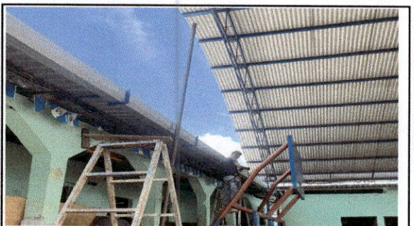
FOTO 4: Sustrucción de canal de metal En modulo de aulas
